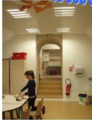
Centre de loisirs MONTRIGAUD Ad'Ap pose plateforme élévatrice
