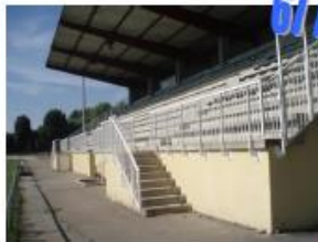
Tribunes René GAY – Chaufferie et Ad'Ap et étanchéité des gradins
