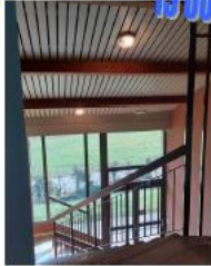
Ecole élémentaire B. ROCHAS Ad'Ap traitement des escaliers et accès à la cour
