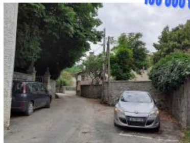
Rue des Gaveaux et rue du Loup enfouissement des réseaux aériens
